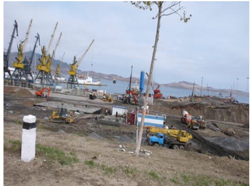
4호 부두 공사 착공
