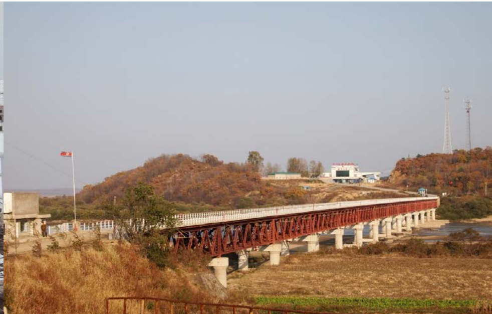
교량 공사 완공 후
