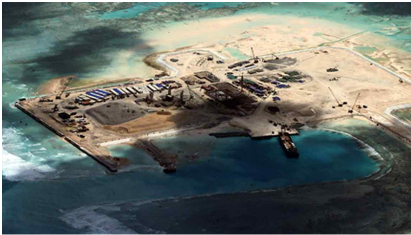
그림 2 중국의 남중국해 인공섬 공사 모습
