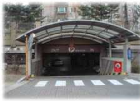
아파트 주차장 대피시설
