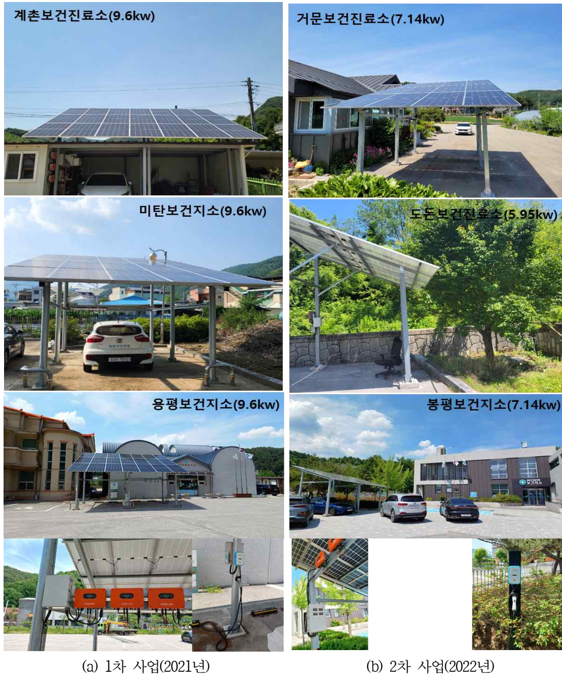
[그림 18] 평창군 보건지소 태양광 발전설비 설치 모습 21)
