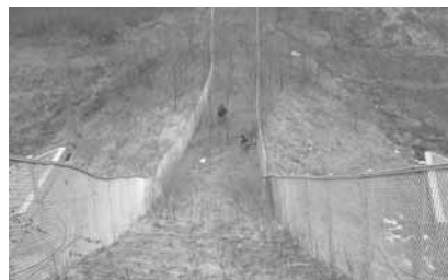
그림 2 전북 무주군 노루고개 야생동물 이동통로 상부 전경
