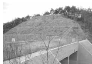
그림 34 야생동물이동통로의 상부 전경
