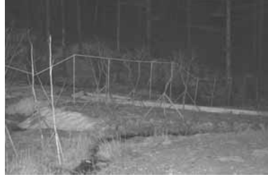
그림 6 강원 강릉시 왕산면 송현리 삼당령 야생 동물 이동통로의 유도펜스 설치사진
