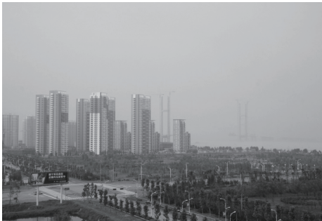
<단둥 신도시와 건설 중인 신압록강대교>
